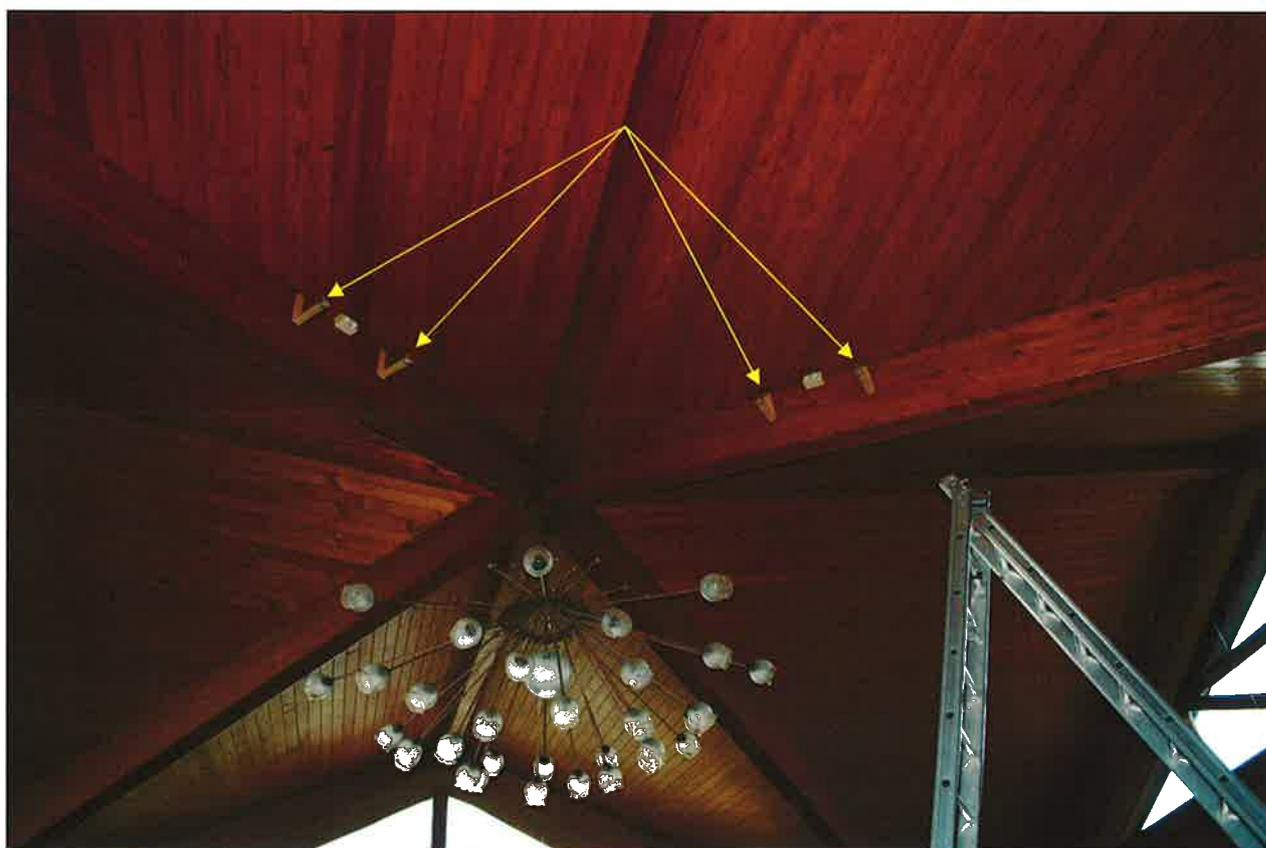
**Contrôle de la capacité de suspension des 4 équerres
