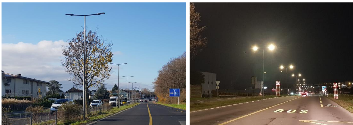
Mise en service décembre 2025
