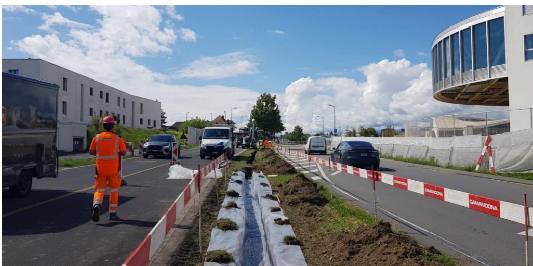
Travaux en cours de réalisation
