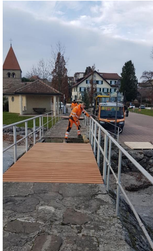
Remise en état du ponton du Débarcadère
