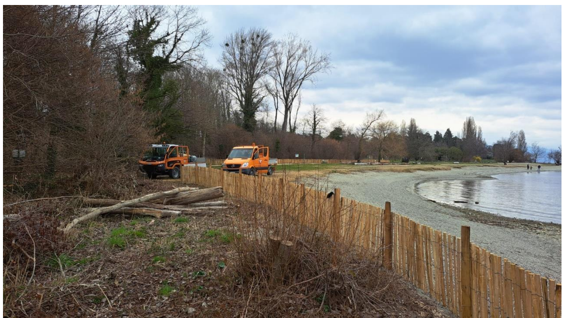
Pose de clôtures en bois (ganivelles) à la plage du Laviau
