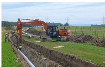
Sur sol sec et enherbé, les machines peuvent circuler librement en respect de leur limite d'intervention spécifique
