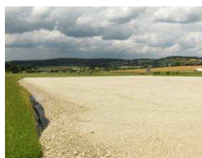
Aire d'installation de chantier préparée en disposant un matelas protecteur en grave
