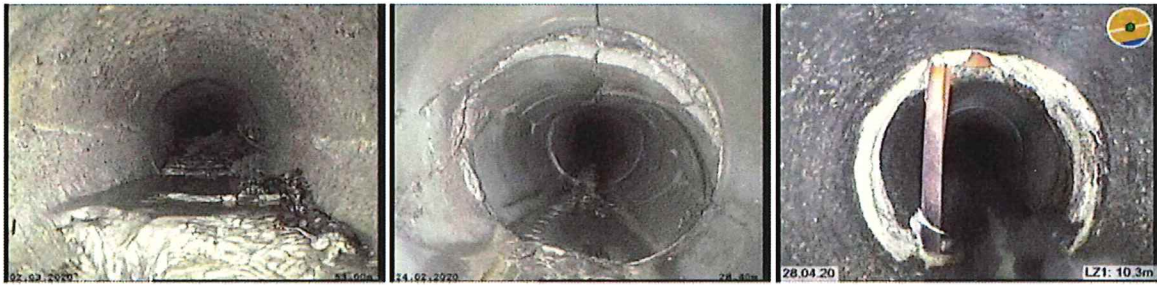
Dépôts durs (exemple - chemin du Pâqueret)
