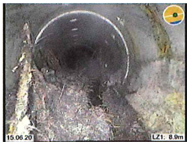
Présence de racines (exemple du collecteur EC - RC1)
