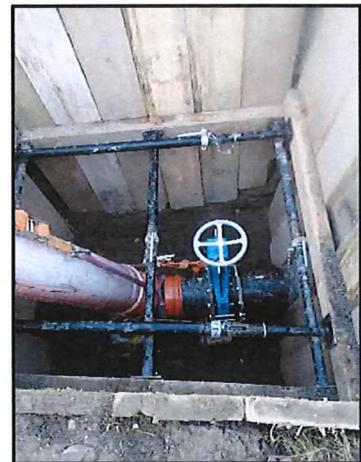
15.02.2021 : L'acheminement des EU étant sécurisé via le bypass, il est procédé, dès le lundi 15 février 2021, au démontage de la pièce défectueuse par l'entreprise Perret Sanitaire SA. À cette occasion, il est constaté par le sanitaire que la corrosion s'étend au-delà de la fosse de pompage (cf. photos ci-dessous) et que les réparations ne peuvent se limiter à un simple changement de la pièce fuyarde.
