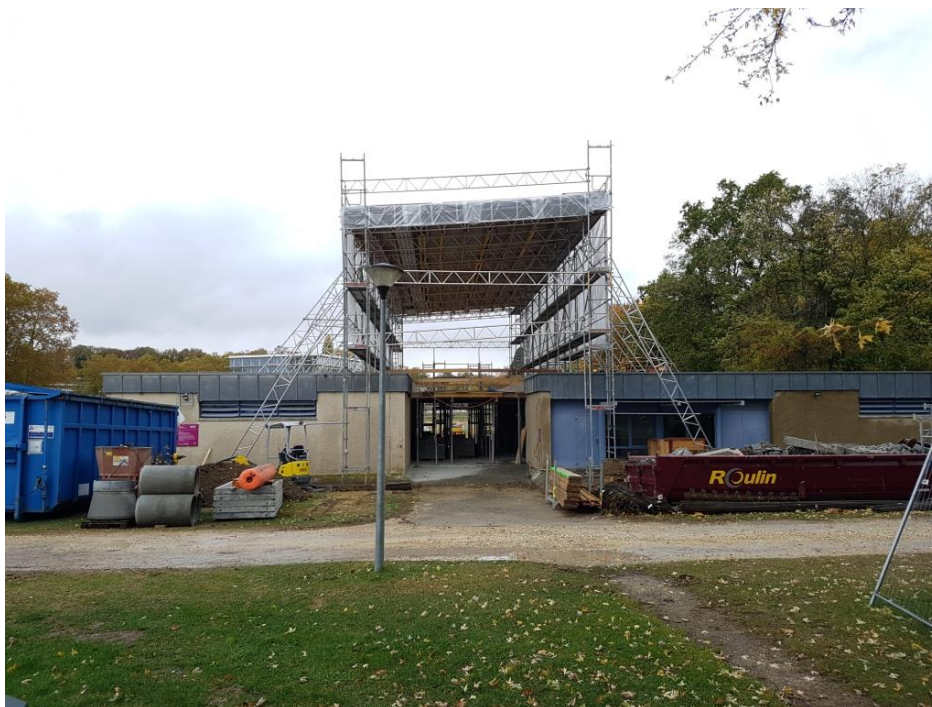
Chantier terrains de Dorigny
