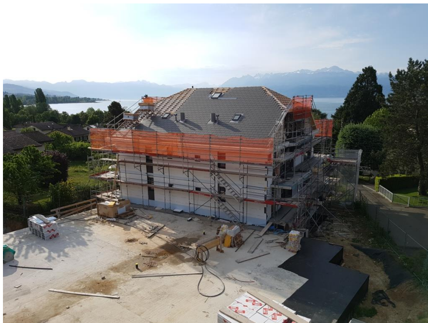
Chantier à la Route Cantonale 19
