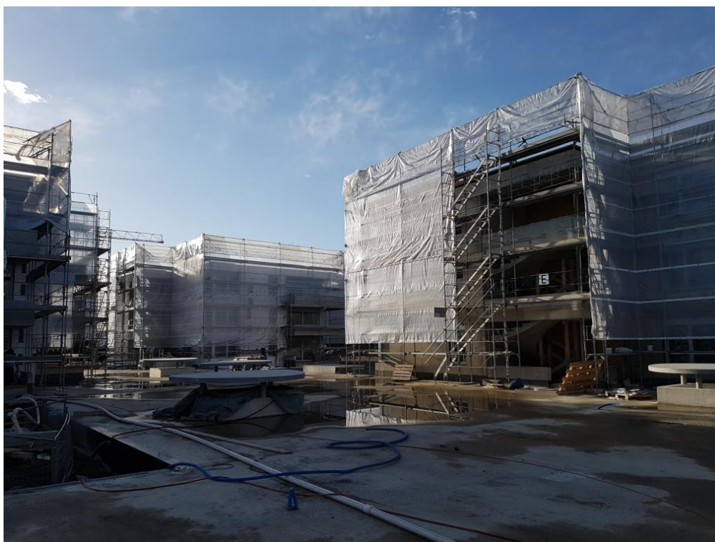
Chantier Jardins de la Venoge
