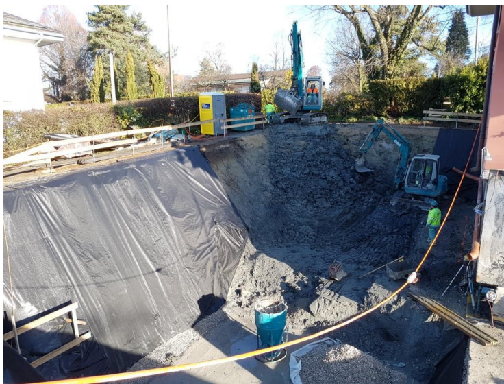
Chantier chemin du Marquisat 15
