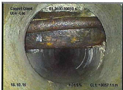
3. Conduite traversant le collecteur
