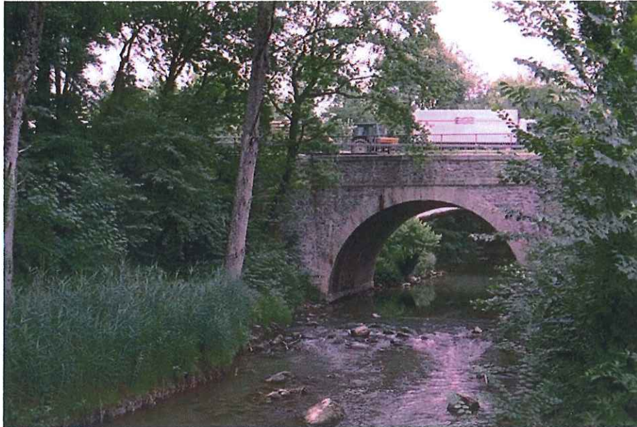
Figure 10 : Pont sur la Venoge (vue côté sud)
