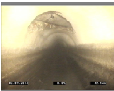
1. Piquage du collecteur pour permettre traversée collecteur avec rhabillage non effectué
