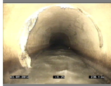
2. Défaut d'étanchéité avec fissuration relevée sur le joint entre tuyaux
