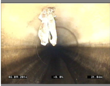
1. Perforation du collecteur avec rhabillage apparent
