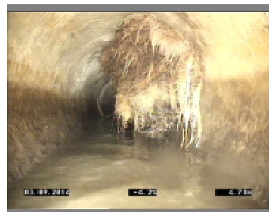
3. Perforation avec importante pénétration de racines
